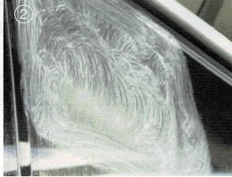
② 液剤の容器をよく振って中身を攪拌します。液剤をガラスに適量(パチンコ玉 2~3 個分)付け、スポンジ等で 30~40cm角に均一に塗り広げます。
