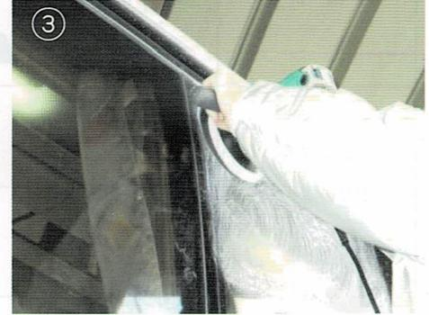
③ ポリッシャーに専用パッドを装着し、低速回転で研磨します。約 30cm角ずつ縦横にクロスカットで確実に研磨除去してから次の部分へ移行して下さい。
